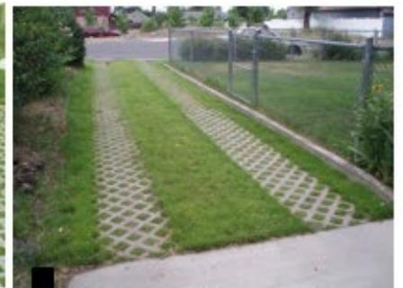
Structure béton alvéolé avec bande de roulement
